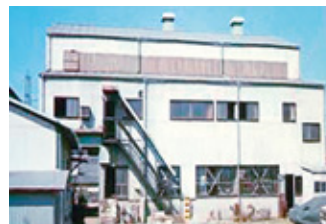
黒木溶接工業(株)堺工場(堺市)
