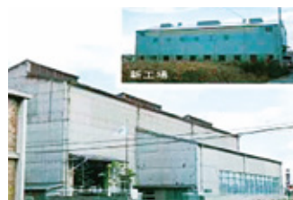
黒木溶接工業(株)本社(姫路市)
